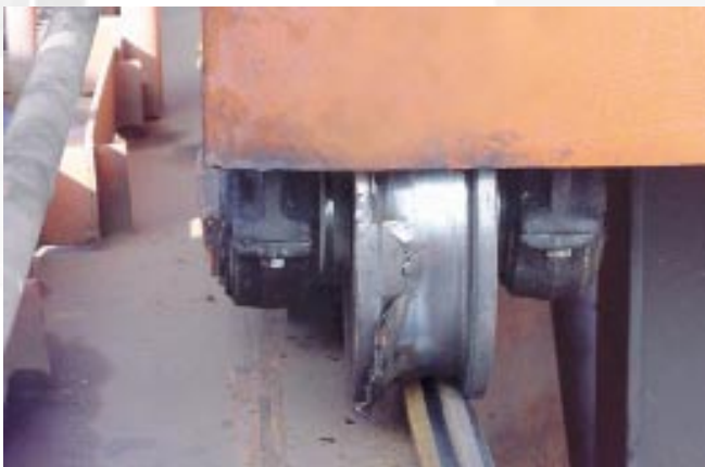
Durch fehlerhafte Achsgeometrie beschädigtes Laufrad
